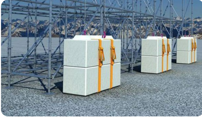
Abspannungen von Gerüsten und Tribünen
