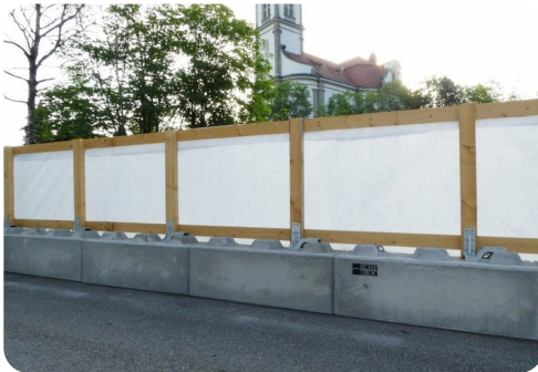
Baustellen- und Verkehrssicherung
